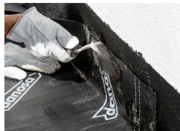
Imagen 44: colocación en encuentro con elemento vertical, forma "L". Fuente: leroy merlin
