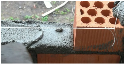
Imagen 29: colocación de segunda hilada. Fuente: videos Jevibe.
