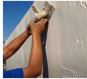
Imagen 83: extendido de mortero. Fuente: TRUCCSA
