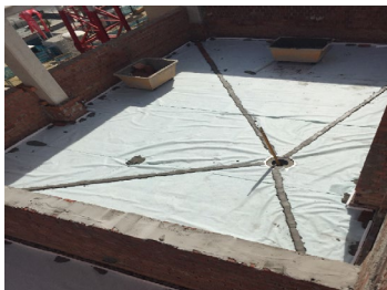
Imagen 66: ejecución de cubierta. Fuente: D. Adrián Rebollo Herrera
