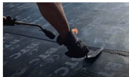
Imagen 46: extendido de unión con paleta. Fuente rudeco.
