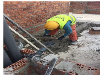
Imagen 67: ejecución de cubierta. Fuente: D. Adrián Rebollo Herrera
