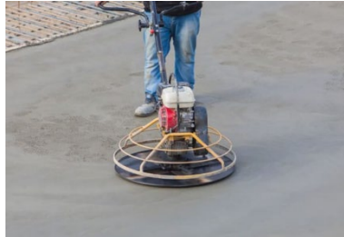
Imagen 121: fratasado. Fuente: pavimento impreso Castellón.
