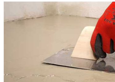
Imagen 96: aplicación de pasta niveladora. Fuente: pinterest.
