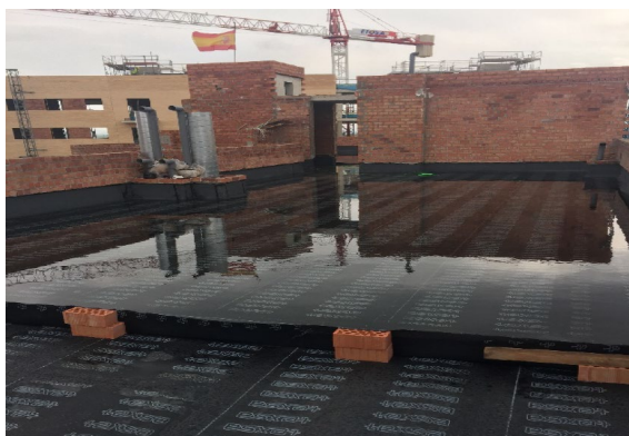
Imagen 50: prueba de estanqueidad. Fuente: D. Adrián Rebollo Herrera.
