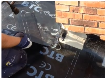
Imagen 47: unión a elemento vertical. Fuente rudeco.
