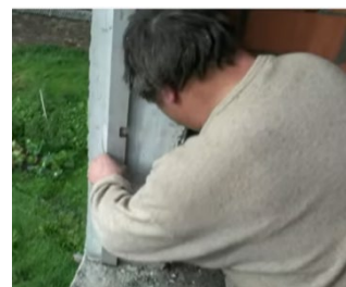
Imagen 7: nivelación y toma de medidas en la parte inferior del pilar. Fuente: videos Jevibe.
