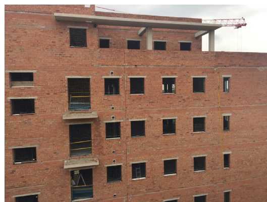
Imagen 38: fachada terminada. Fuente: D. Adrián Rebollo Herrera
