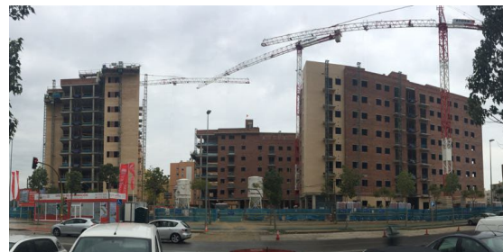
Imagen 3: vista general de la obra. Fuente: D. Adrián Rebollo Herrera
