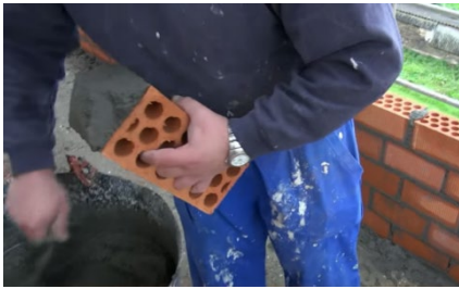
Imagen 23: aplicación de mortero. Fuente: videos Jevibe.
