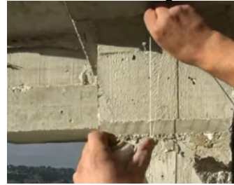
Imagen 9: colocación de cuerda en la parte superior. Fuente: videos Jevibe.
