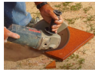
Imagen 65: corte baldosa. Fuente: gres de Nava.
