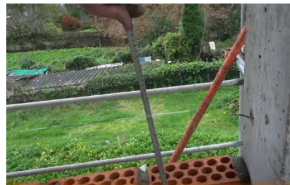
Imagen 28: recolocación de tirantez. Fuente: videos Jevibe.
