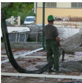
Imagen 118: vertido de hormigón. Fuente: toffolo.
