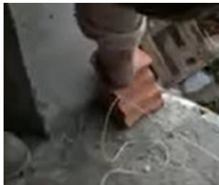
Imagen 14: ajuste de guía horizontal. Fuente: videos Jevibe
