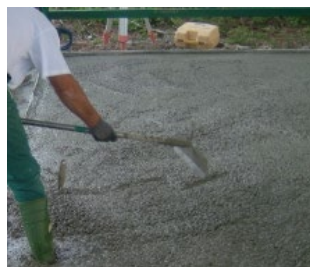
Imagen 119: extendido de hormigón. Fuente: toffolo.
