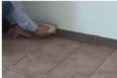
Imagen 104: enlechado de juntas con pasta. Fuente: en todo el mundo
