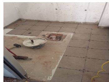
Imagen 102: colocación de solado. Fuente: D. Adrián Rebollo Herrera.
