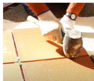
Imagen 60: colocación de baldosa. Fuente: gres de Nava
