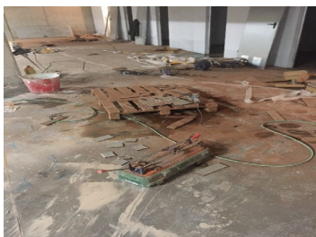
Imagen 101: zona de acopio y corte de solería. Fuente: D. Adrián Rebollo Herrera.
