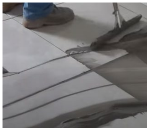
Imagen 99: aplicación de enlechado. Fuente: knauf.
