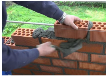
Imagen 24: colocación de ladrillo. Fuente: videos Jevibe.
