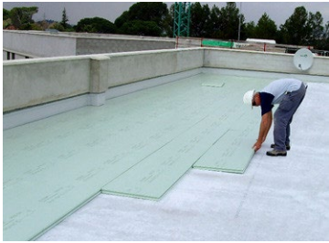
Imagen 56: colocación aislante. Fuente: flickriver.
