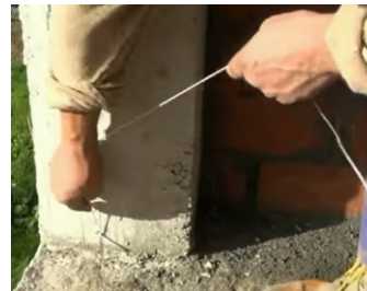
Imagen 11: colocación de cuerda en la parte inferior. Fuente: videos Jevibe.
