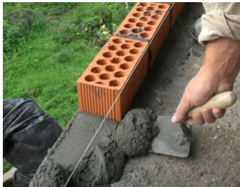
Imagen 25: retirada de mortero. Fuente: videos Jevibe.
