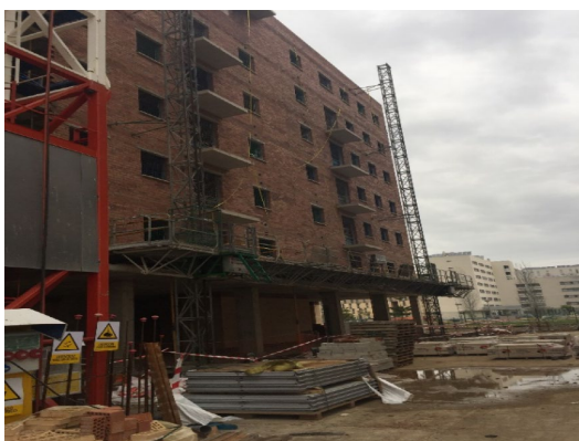
Imagen 37: ejecución de fachada. Fuente: D. Adrián Rebollo Herrera.
