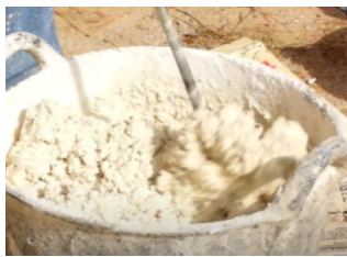
Imagen 63: mezcla de mortero cola. Fuente: gres de Nava
