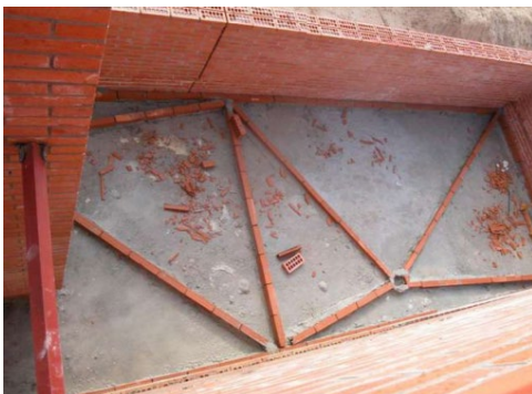
Imagen 39: hiladas de ladrillo para formación de líneas de intersección. Fuente: digibug.
