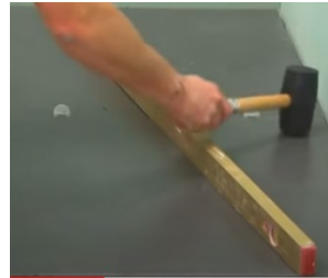
Imagen 98: colocación de baldosa. Fuente: knauf.
