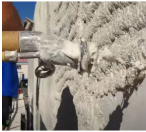
Imagen 82: proyección de mortero. Fuente: TRUCCSA.
