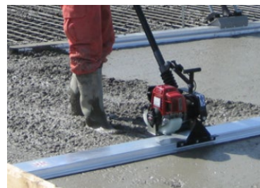
Imagen 120: vibrado y alisado de hormigón. Fuente: ENAR.
