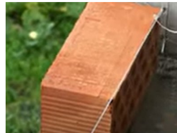
Imagen 15: ajuste de guía horizontal. Fuente: videos Jevibe
