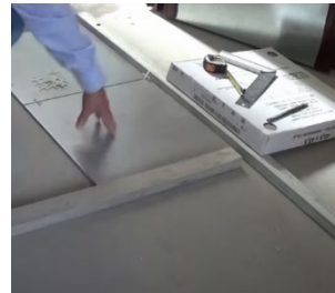
Imagen 93: replanteo con listones. Fuente: en todo el mundo.
