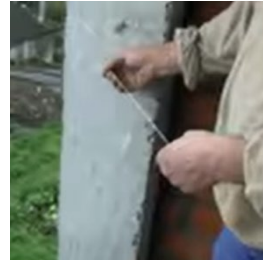
Imagen 13: colocación guía horizontal. Fuente: videos Jevibe
