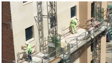
Imagen 86: capa de acabado de revestimiento. Fuente: D. Adrián Rebollo Herrera.
