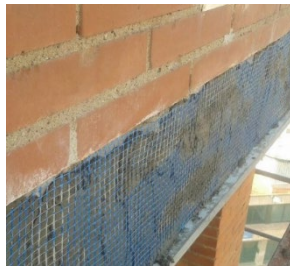
Imagen 78: colocación de malla en forjado. Fuente: revest 95.
