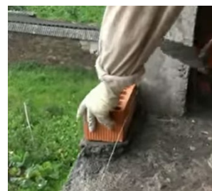
Imagen 22: colocación de primera hilada. Fuente: vídeos Jevibe.
