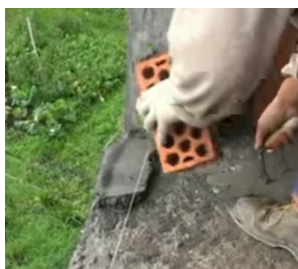
Imagen 21: colocación de primera hilada. Fuente: vídeos Jevibe.
