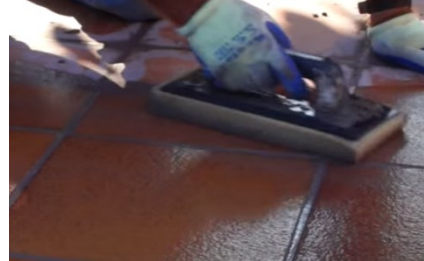
Imagen 62: limpieza de juntas. Fuente: gres de Nava
