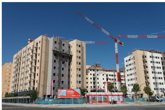
Imagen 2: vista general de la obra. Fuente: D. Adrián Rebollo Herrera.
