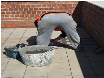
Imagen 68: ejecución de cubierta. Fuente: D. Adrián Rebollo Herrera
