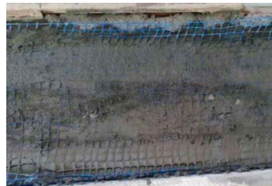
Imagen 79: proyección de mortero sobre malla. Fuente: revest 95.
