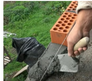
Imagen 26: retirada de mortero: Fuente: videos Jevibe.
