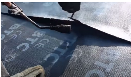
Imagen 45: aplicación de calor con soplete. Fuente rudeco.
