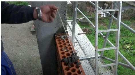
Imagen 27: recolocación de tirantez. Fuente: videos Jevibe.
