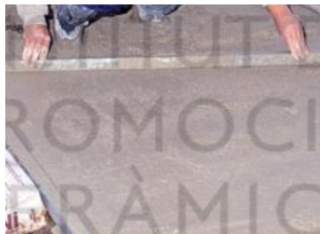
Imagen 95: maestreado de mortero. Fuente: IPC.
