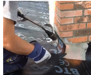
Imagen 48: unión a elemento vertical. Fuente rudeco.
