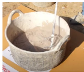
Imagen 64: mezcla de rejuntado. Fuente: gres de Nava
