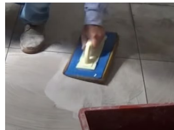
Imagen 100: limpieza de superficie. Fuente: knauf.
