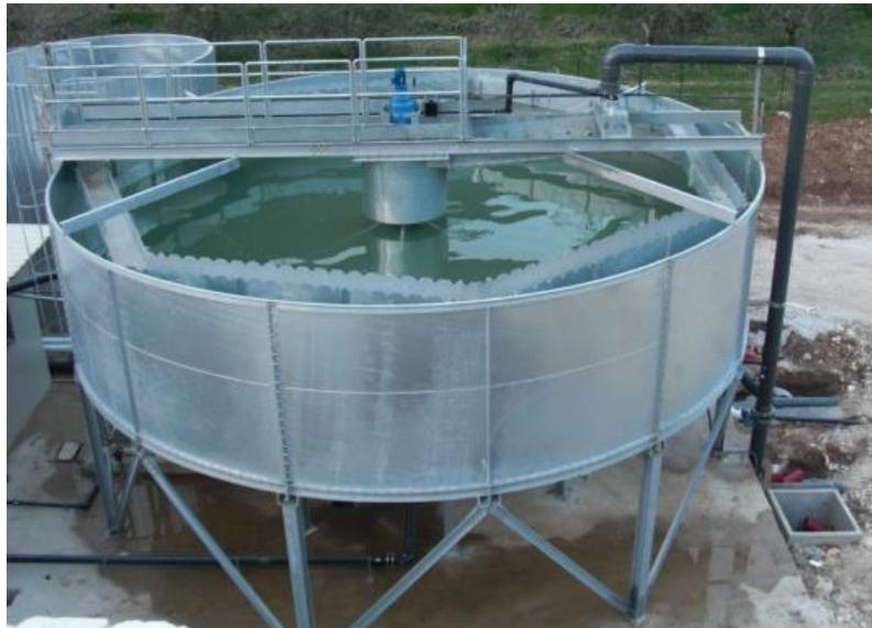
Ilustración 14. Decantador dinámico. Fuente: (POGGI-SPA, 2019)
