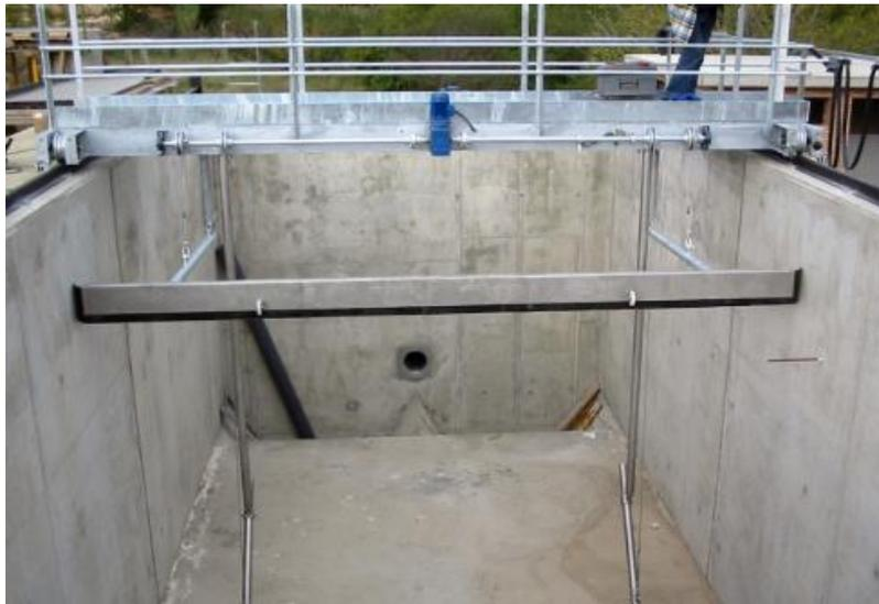
*Ilustración 16. Decantador rectangular. Fuente: (VICTORIANO MAQUINARIA S.L., 2019)*
