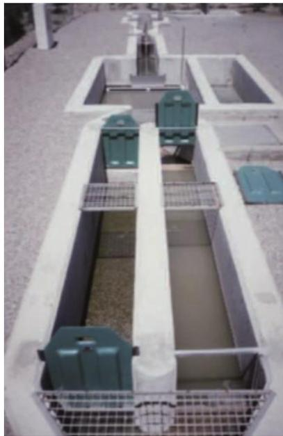
*Ilustración 6. Desarenador estático de doble canal. Fuente: (Ortega, Ferrer, Salas, Aragón, & Real, 2010)*
