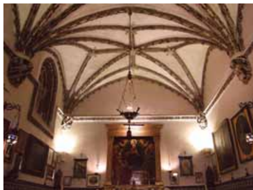
Figura 4. Bóveda en la capilla del Palacio de las Dueñas. Sevilla.
