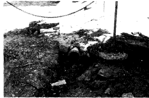
Figura 7 Saneamiento actual dentro de las ruinas.
