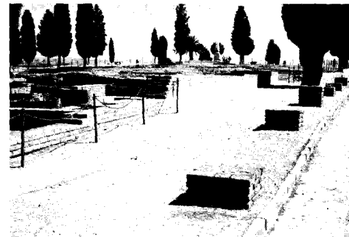
Figura 10 Reconstrucción de parte inferior de porche y vivienda en itálica.
