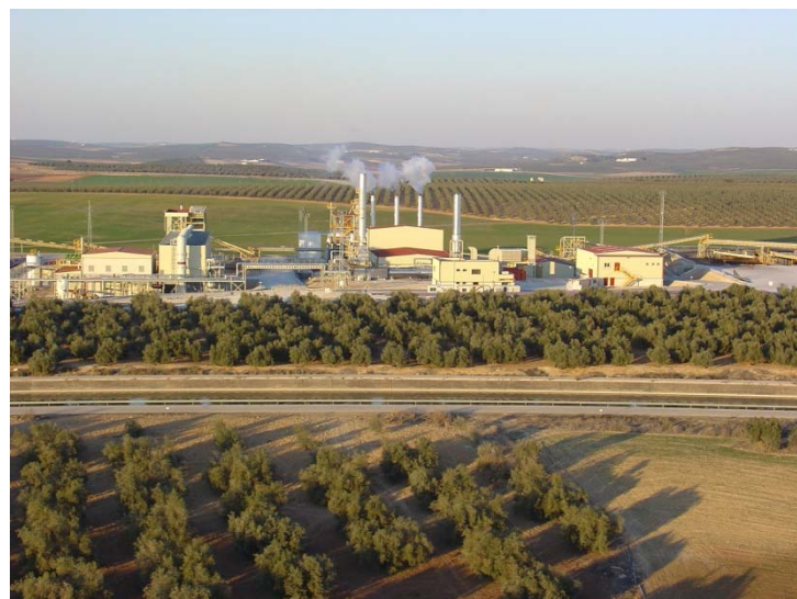
Figura 3. Planta de cogeneración para el secado del alperujo y producción de energía eléctrica con la biomasa residual en Ponte Genil (Córdoba).
