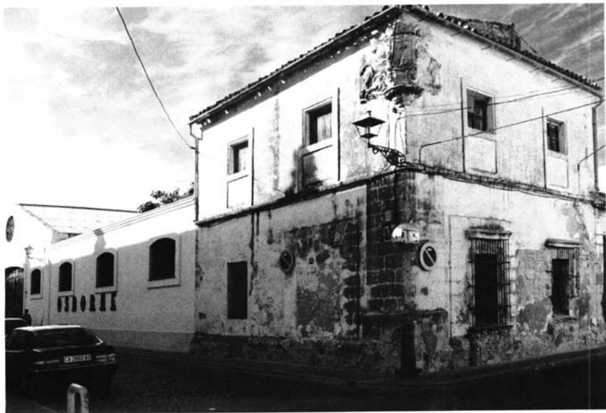
1.- Vista actual de la casa de las Cuatro Esquinas o la Carraca. Fachada a la calle de los Moros esquina a San Bartolomé.
