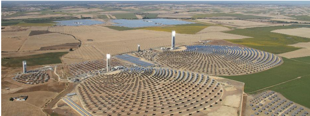
Figura 1.7 Plantas PS-10 y PS-20 de Abengoa en Sevilla (abengoasolar.com).
