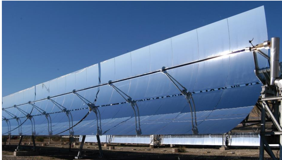
Figura 1.4 Sección de un canal parabólico (ewwind.com).
