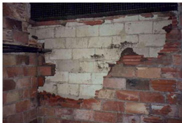
Fig. 5: Proyectado en el interior de cámara
