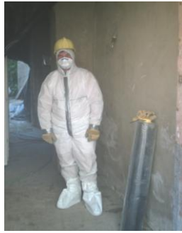
Figura 34: Trabajador con los EPI's colocados correctamente
