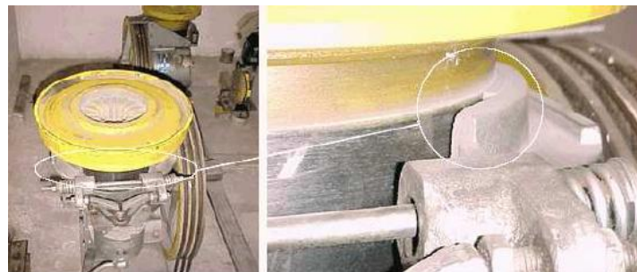
Fig. 19: Sistema de frenado de aparato elevador
