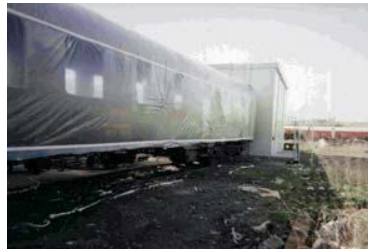
Fig. 28: Ejecución de desamiantado de vagón de tren con borra aislante
