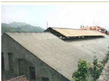
Fig. 1: Cubierta de placas onduladas
