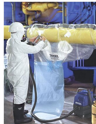
Figura 59: Instalación de glove-bag
