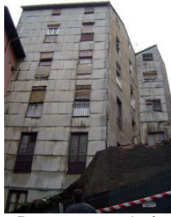
Fig. 3: Paramentos de fachada
