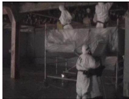
Figura 57: Retirada de amianto proyectado en viga. Elementos auxiliares.
