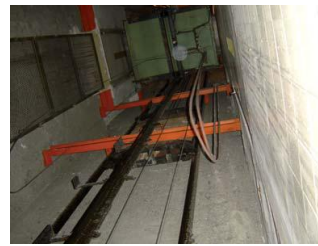
Fig. 6: En el interior de huecos de ascensor
