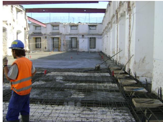
Fig.17-Forjado de planta segunda. Montaje de armaduras. Foto de obra. Año 2009.
