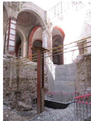
Fig.13-apertura de cuatro bóvedas para el encaje de los núcleos
