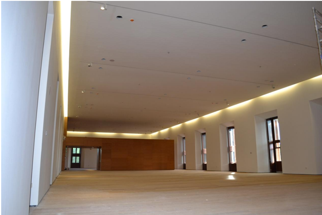
Fig.18-interior de sala de planta primera Bajo forjado postesado. Año 2009.
