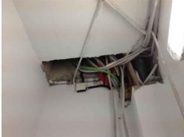
Paso de instalaciones en interior de recinto instalaciones de planta baja donde no se mantiene la compartimentación a través del forjado.
