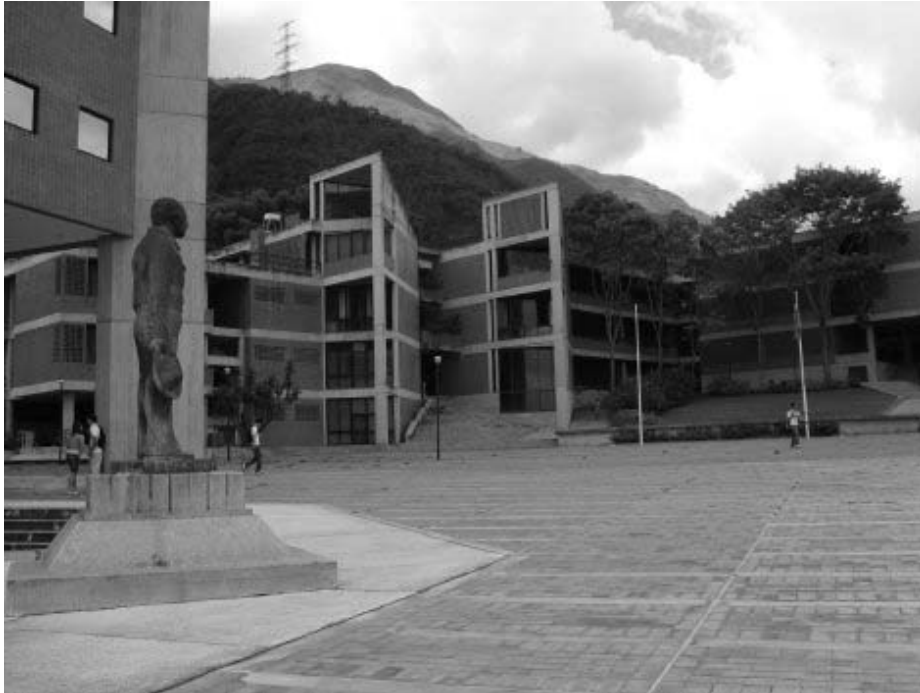
Figura 1-10: Módulo de aulas 1, accesos desde la Plaza del Rectorado.
