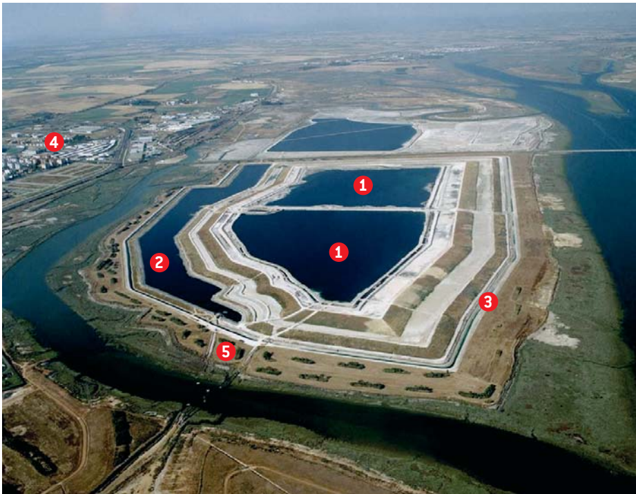
Figura 2. Fotografía aérea [realizada a finales de 2005] de la zona actual de apilamiento de fosfoyesos (área 2). En la fotografía se han marcado las dos balsas de decantación [1], el embalse regulador [2], el canal perimetral [3], la ciudad de Huelva [4] y la localización de la estación de bombeo [5], desde donde se impulsa el retorno de las aguas utilizadas en el transporte del fosfoyeso a las plantas de producción. Se observa también en la fotografía como está creciendo al apilamiento en altura, hasta la obtención de una balsa piramidal, y como los taludes se están recubriendo con una capa de suelo como paso previo de la restauración final de la zona.
