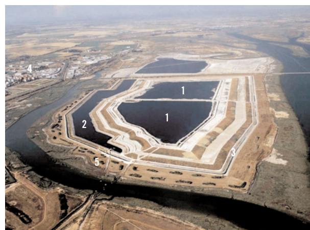
Figura 5.2. Fotografía aérea (realizada a finales del 2005) de la zona actual de apilamiento de fosfoyesos (área 2). En la fotografía se han marcado las dos balsas de decantación (1), el embalse regulador (2), el canal perimetral (3), la ciudad de Huelva (4) y la localización de la estación de bombeo (5), desde donde se impulsa el retorno de las aguas utilizadas en el transporte del fosfoyeso a las plantas de producción
