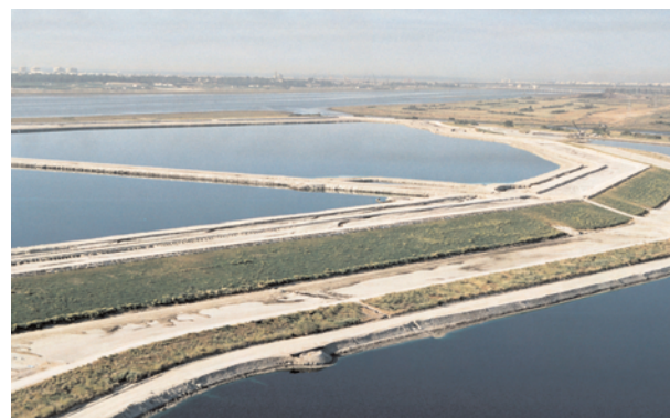
Figura 5.3. Fotografía más detallada de las balsas activas (área 2) donde se observa como el apilamiento está creciendo en altura y cómo los taludes están siendo cubiertos con una capa de suelo y revegetados
