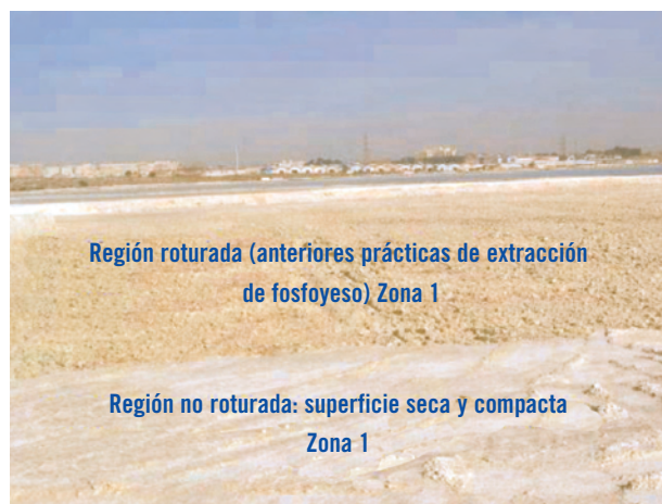
Figura 5.7. Imagen de la balsa de fosfoyeso analizada que muestra la distinción de las zonas I y II. La zona III (no mostrada en la foto) corresponde a los taludes de la balsa
