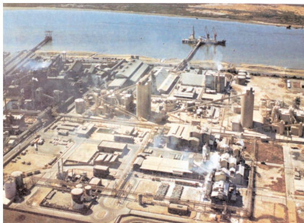
Vista aérea de la fábrica de ácido fosfórico analizada
