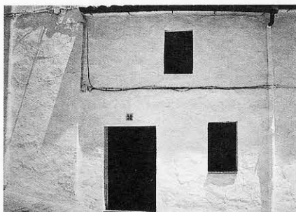
VIVIENDA EN CALLE MAYOR, Nº 30.
