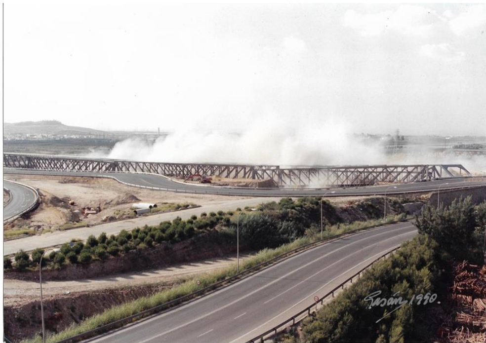
Demolición del Puente de Hierro. Año 1990. Autor: Gasán. Valor histórico e instrumental.
