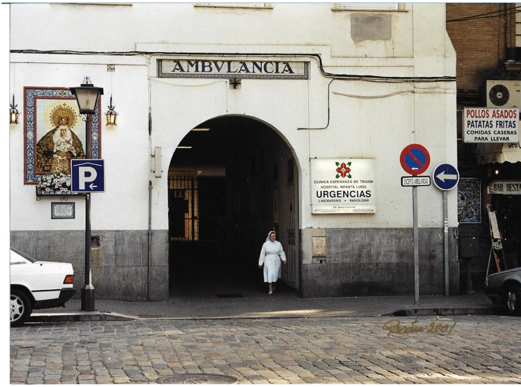
Urgencias del Antiguo Hospital de Santa Isabel antes de su demolición. Calle San Jacinto. Año 2004. Autor: Gasán. Valor rememorativo itencional, histórico e instrumental.
