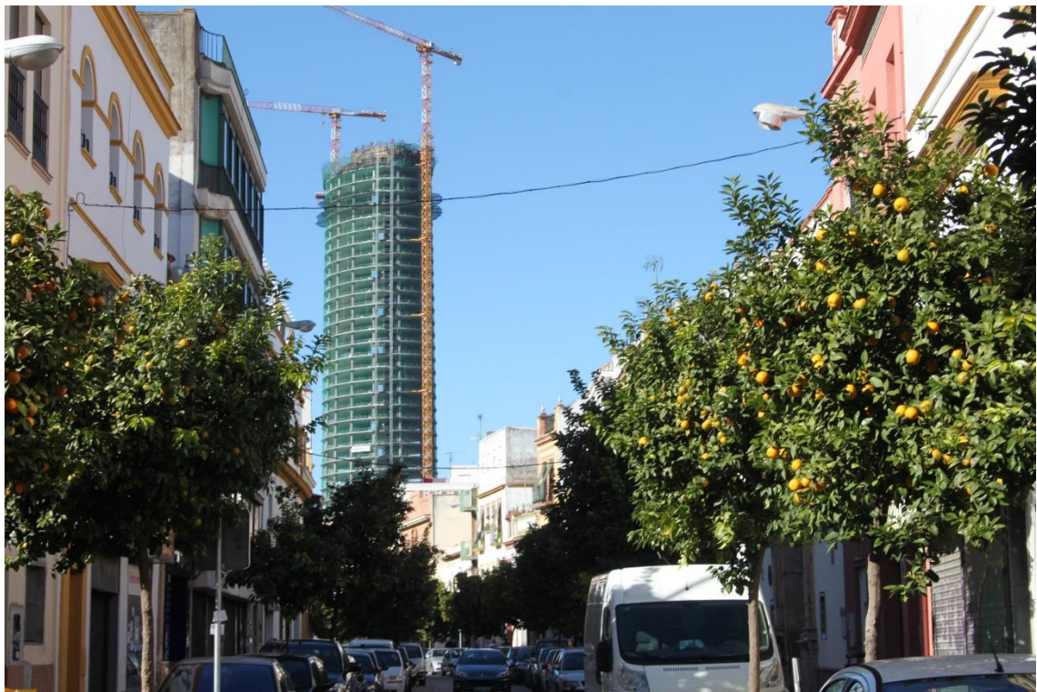
Calle Castilla en dirección Chapina. Proceso de construcción de la Torre Pelli al fondo. Año 2013. Autor Gasán. Valor histórico.
