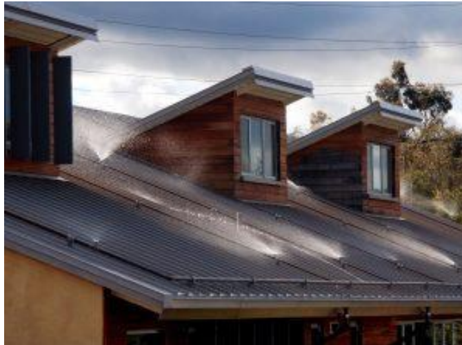
Figura 1-6. Sistema de enfriamiento híbrido evaporativo-radiante.
