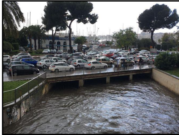
Figura 10. Garajes inundados y tuberías desbordadas por las intensas lluvias caídas en Palma [15].
