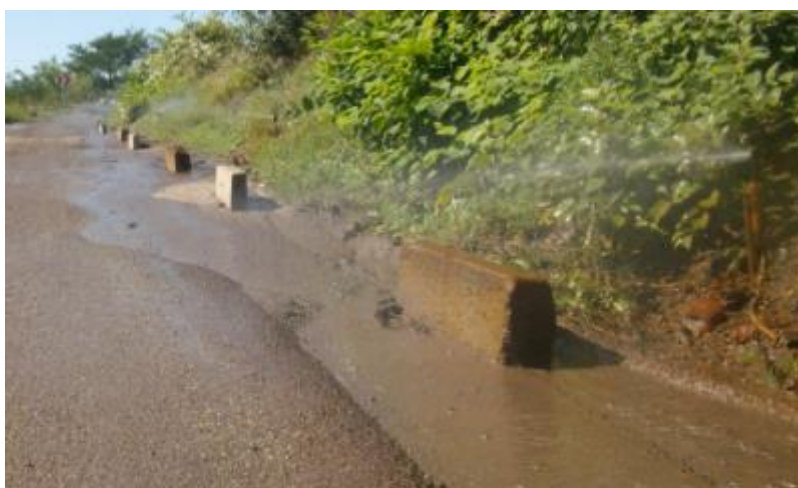
Figura 12. Sistema de irrigación de las pistas que presentan una tonalidad anaranjada.
