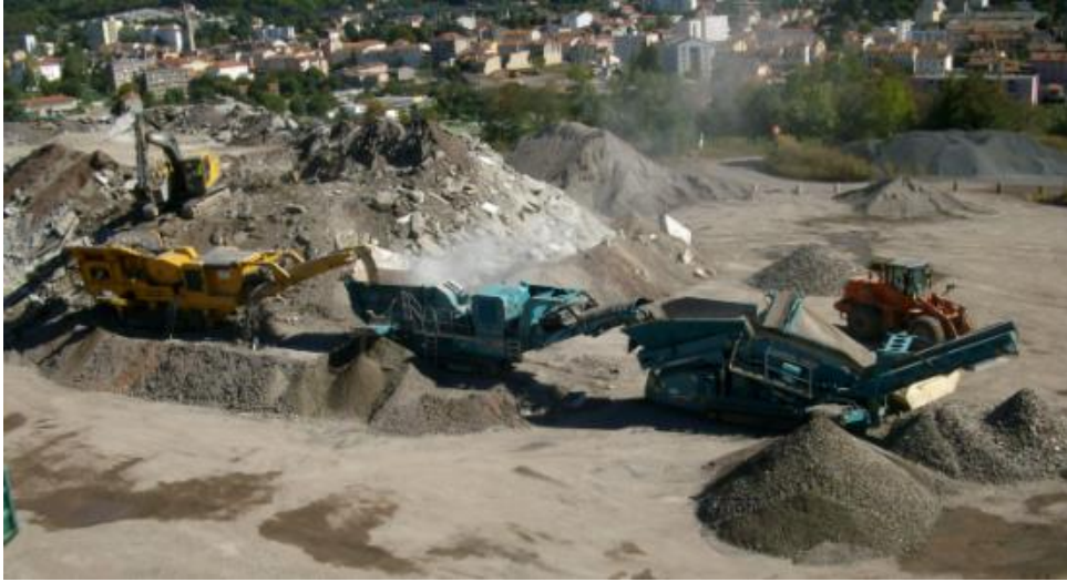
Figura 10. Operación de reciclaje de hormigón
