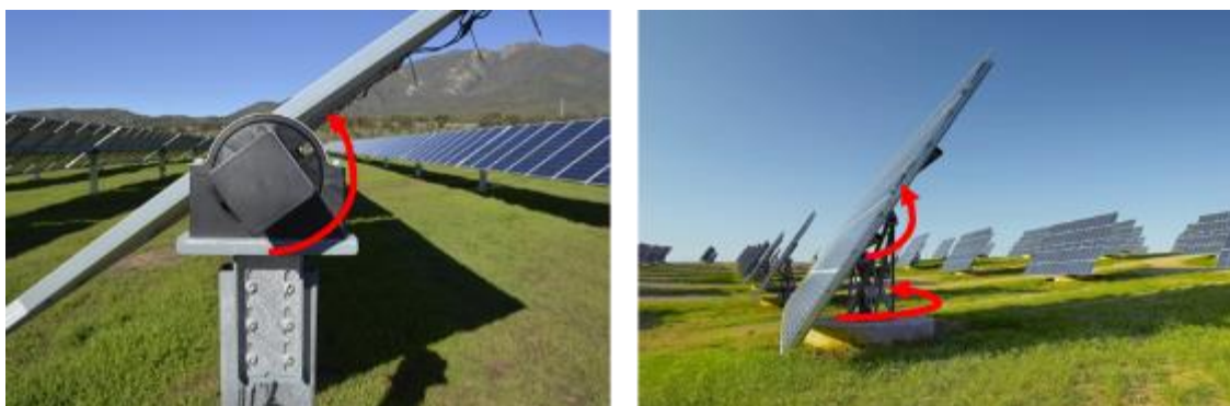
Fig. 155: Resumen: Seguidor de un eje (izquierda) y de dos ejes (derecha)
