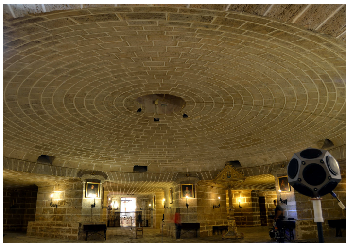
Figura 2 - Vista interior de algunas galerías y de la bóveda de la cripta de la Catedral de Cádiz, tomada durante la campaña de medidas.
