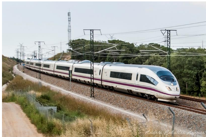
Figura 2-9 AVE S103 en circulación. Romero, A. 2012 “Predicción, medida experimental y evaluación de las vibraciones producidas por el tráfico ferroviario”
