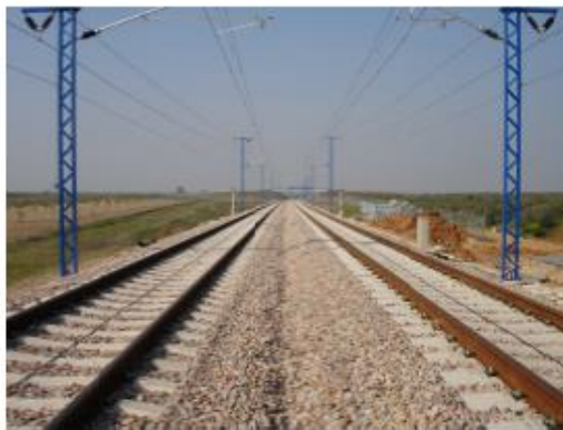
Figura 2-17 Vía de la línea de alta velocidad entre Córdoba y Málaga. Galvín, P., Domínguez, J.,2006, “Vibraciones ocasionadas en el suelo por paso de locomotora”
