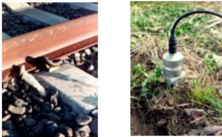
Figura 2-4 Acelerómetro situado en carril y traviesa (izquierda) y acelerómetro situado sobre estaca de aluminio (derecha). Degrande, G. 2002. “Free field vibration measurements during the passage of a Thalys high speed train”
