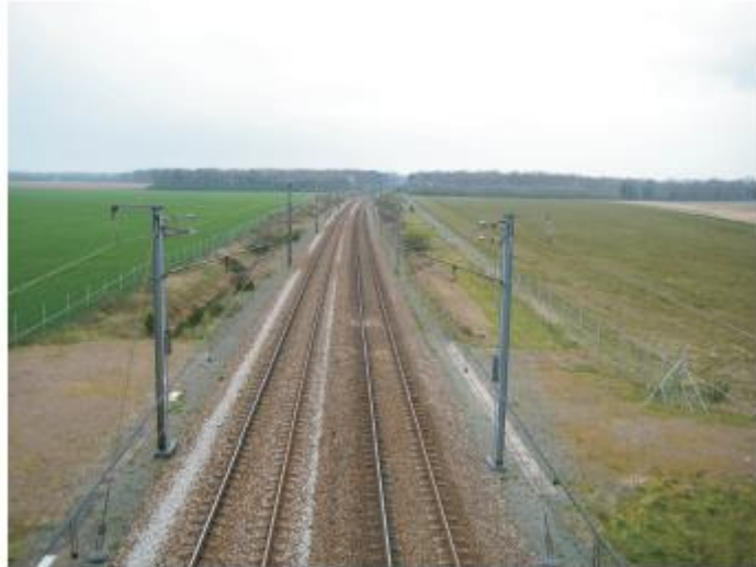
Figura 2-32 Línea atlántica LGV, donde se realizaron los ensayos. Lombaert, G., Galvín, P., Degrande, G., 2009, “Prediction of railway induced vibrations at a site in Reugny (France)”
