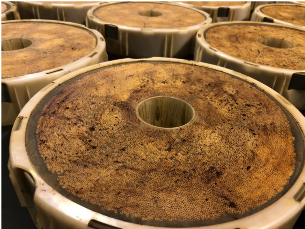
Figura 30 Inspección de membranas de ultrafiltración sucias, (Instantánea de planta)
