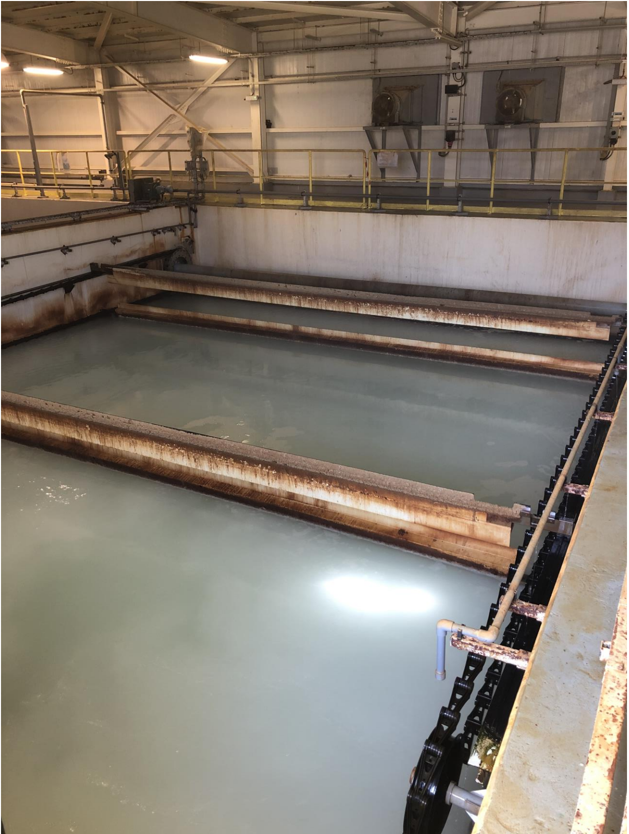
Figura 20 Celda DAF, (Instantánea de planta)
