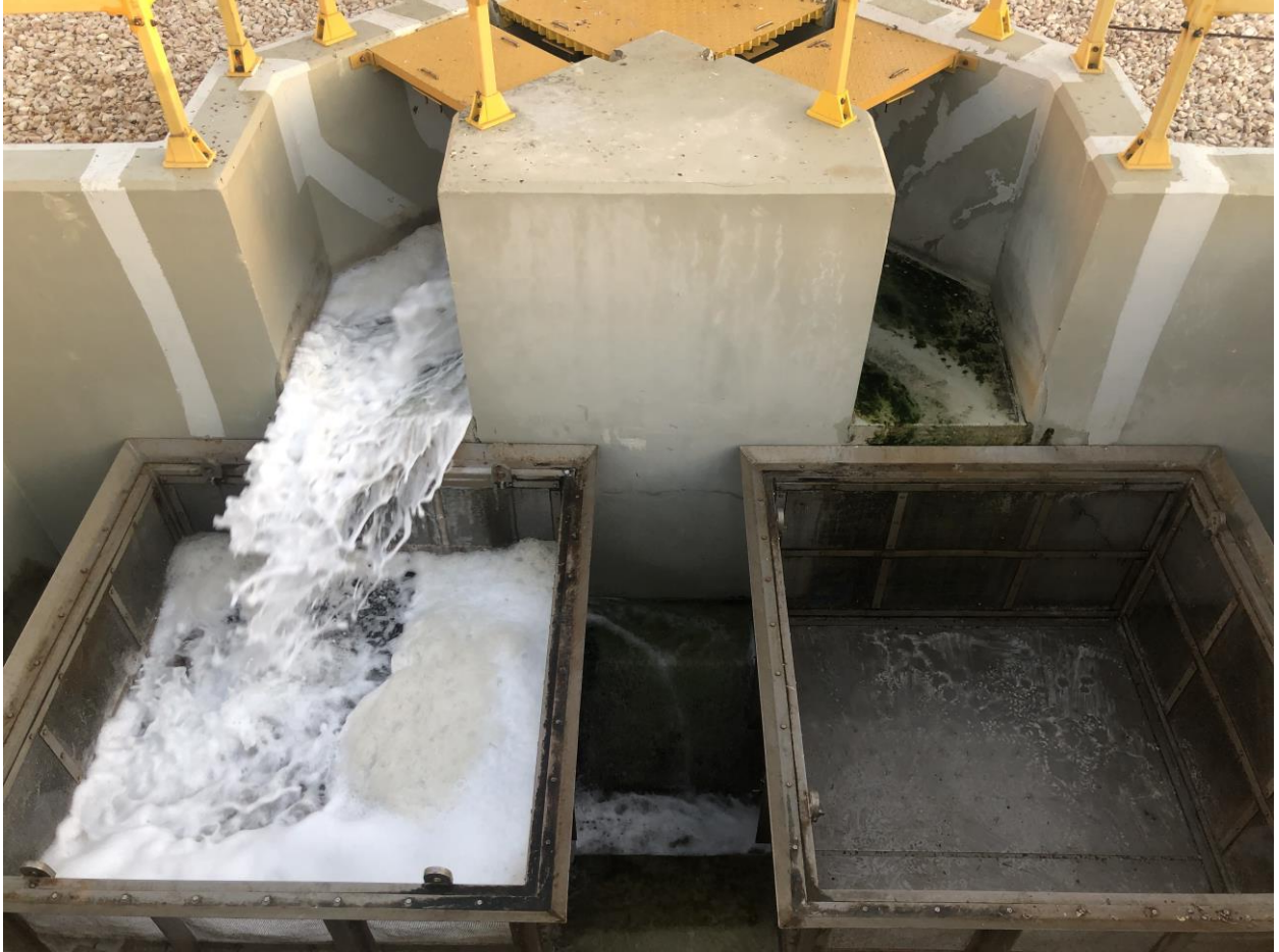
Figura 14 Cestas de recogida de escombros, (Instantánea de planta)
