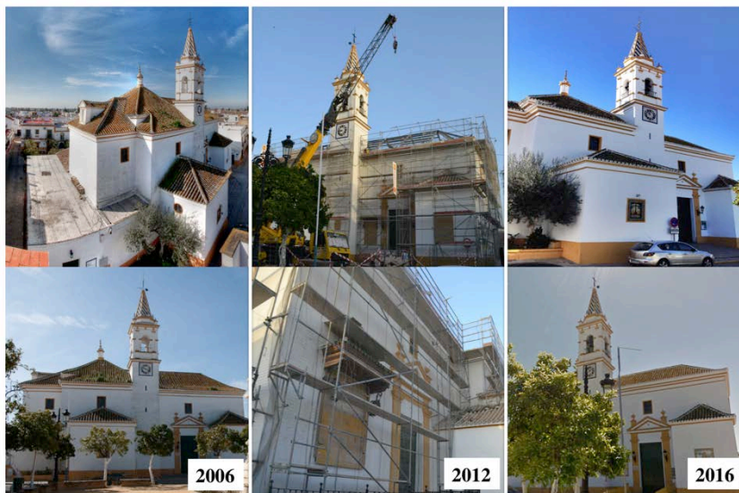
Figure 2: Parroquia Ntra. Sra. de la Estrella de Valencina de la Concepción antes de la intervención integral de cubierta en 2006, durante la intervención en 2012 y posterior a la intervención en 2016.
