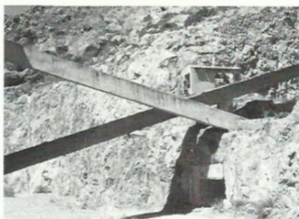
Estructuras de las cintas transportadoras.
