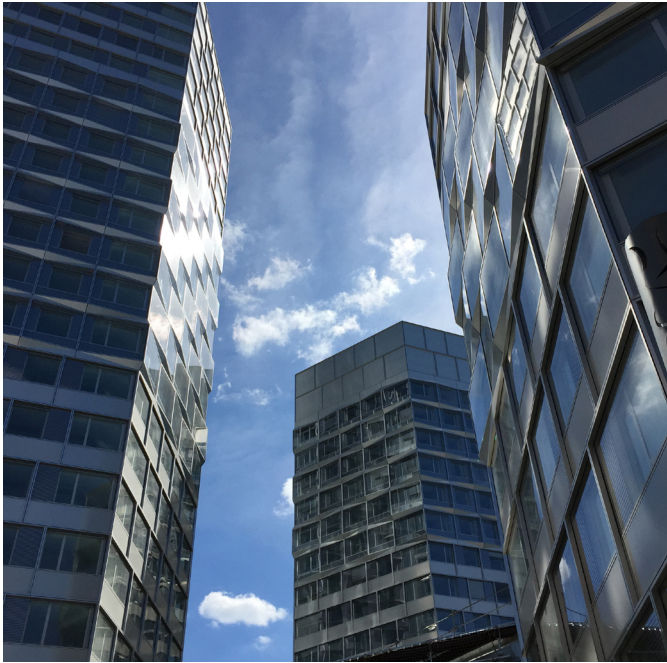
Rehabilitación de las torres del Pont de Sèvres, Boulogne-Billancourt (2007-2015) | foto © Dominique Perrault Architecte / Adagp
