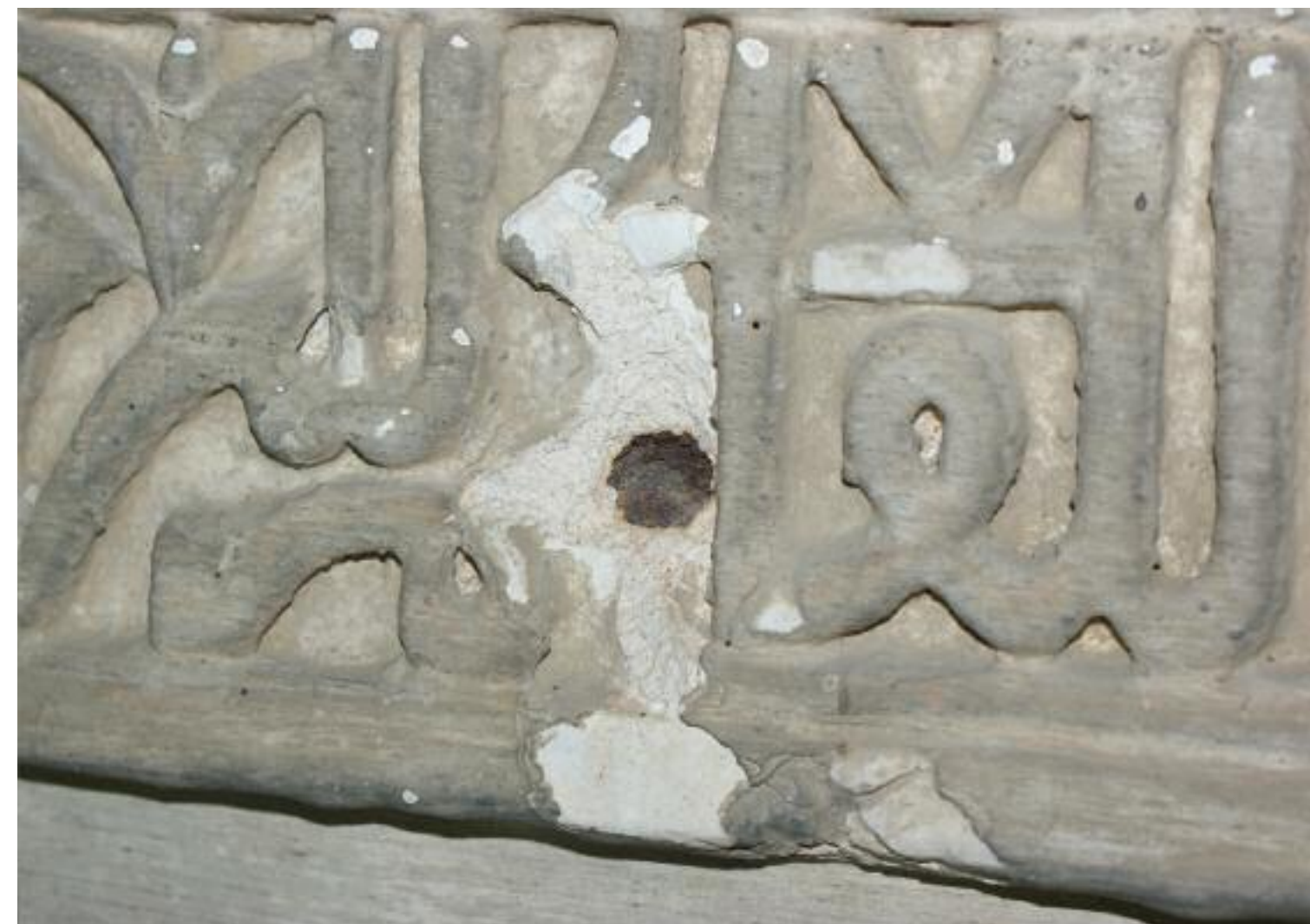
Figura 9. Detalle de los clavos de hierro que sostienen las placas de yeserías de GCA.
