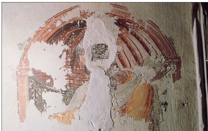
11. Decoración pictórica cubierta por una capa de cal en los paramentos de la Sacristía
