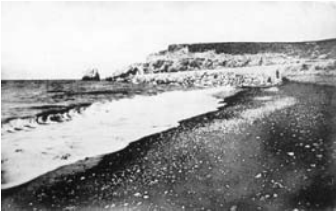
Salida del túnel nº 1 (Km 7).
