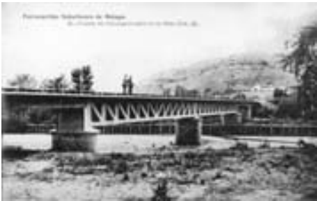
Puente del ferrocarril sobre el río Vélez.
