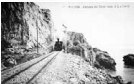
El tren saliendo del túnel de La Cala.
