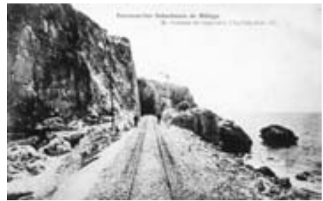
Entrada a los túneles de La Cala.
