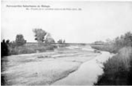
Puente de la carretera sobre el río Vélez, hoy en desuso.
