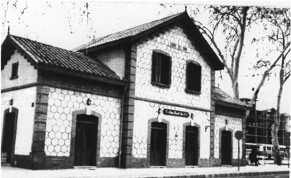
10. Torre del Mar. Fachada Principal. Lateral Izquierdo. 1985.
