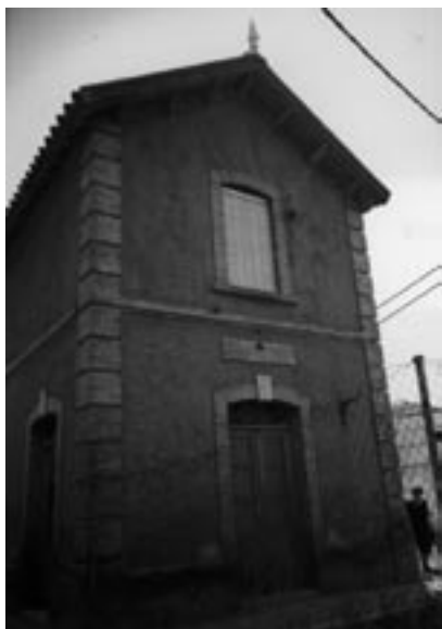
18. Estado actual del antiguo apeadero Trapiche.
