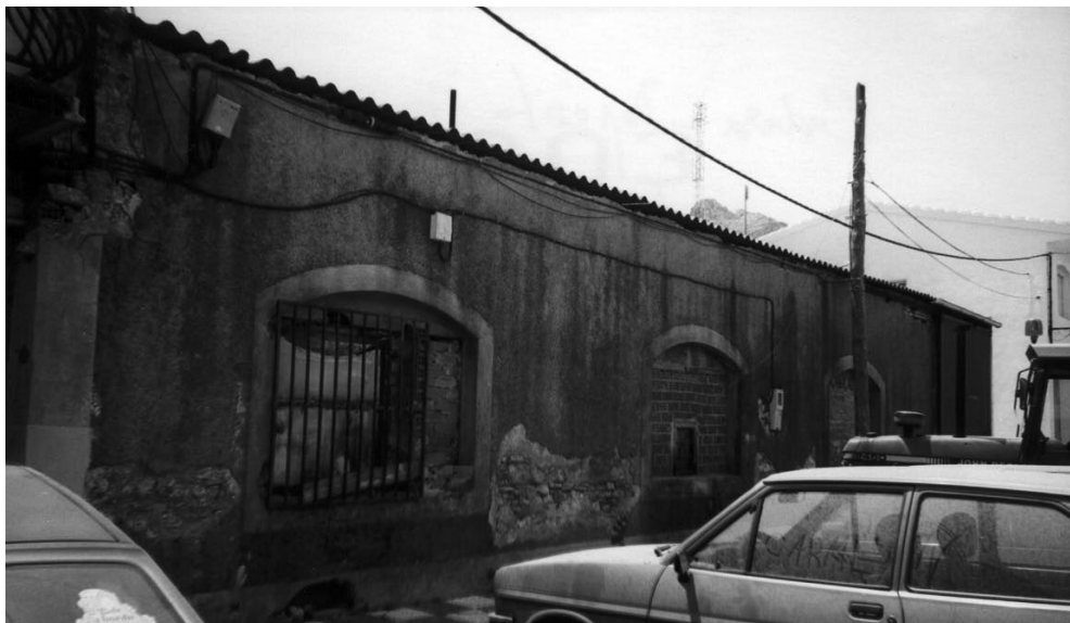
29. Cochera y depósito de la antigua estación.
