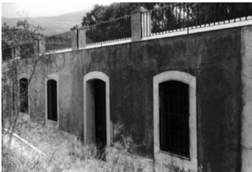
22. Detalle de los únicos elementos originarios que quedan de la antigua estación de Matanzas.
