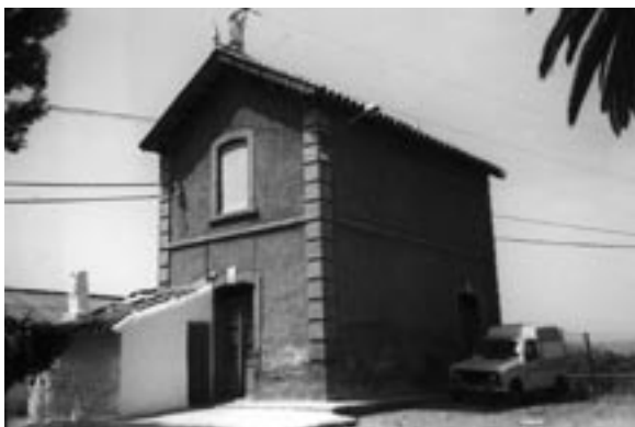
19. Estado actual del antiguo apeadero Trapiche.
