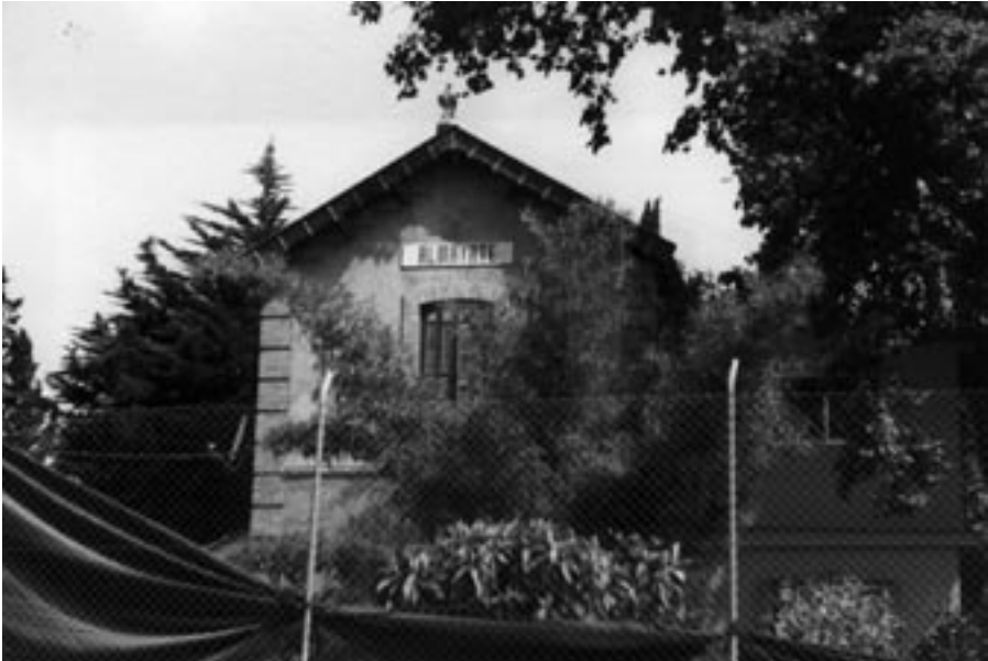
7. Estado Actual del Apeadero de Almayate.
