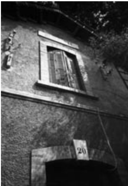
8. Detalle de la fachada del Apeadero Almayate.
