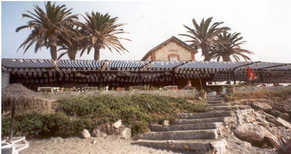
9. Vista general desde la playa del antiguo apeadero de Chilches.
