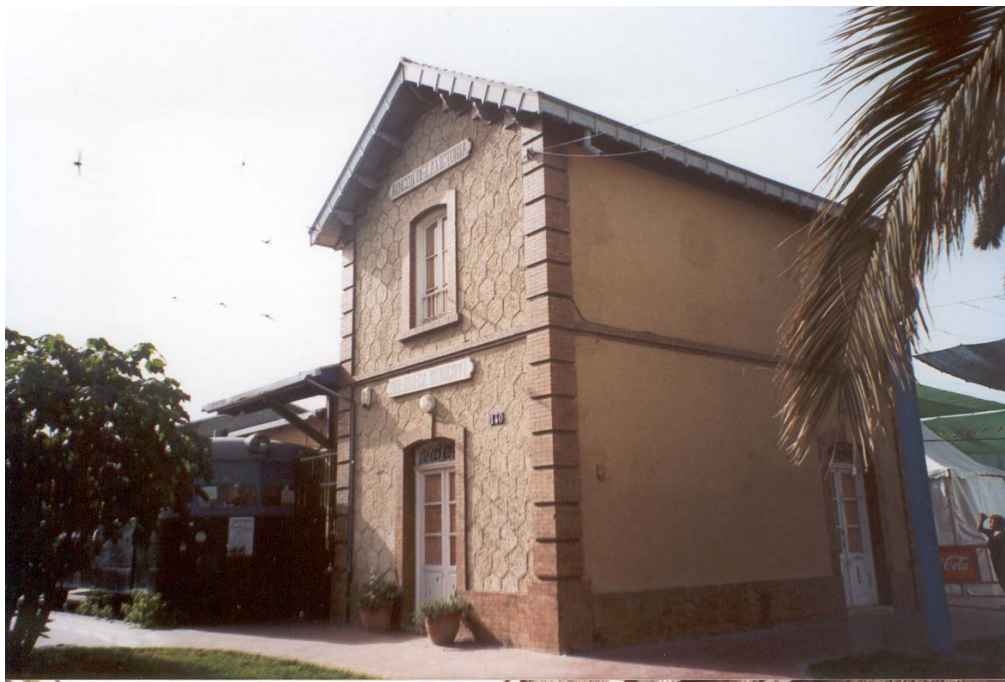
5. Imagen actual de la estación del Rincón de la Victoria después de su rehabilitación
