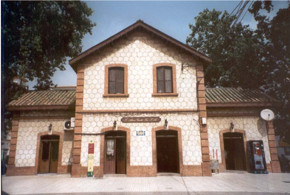
13. Torre del Mar. Fachada principal. Actualmente.
