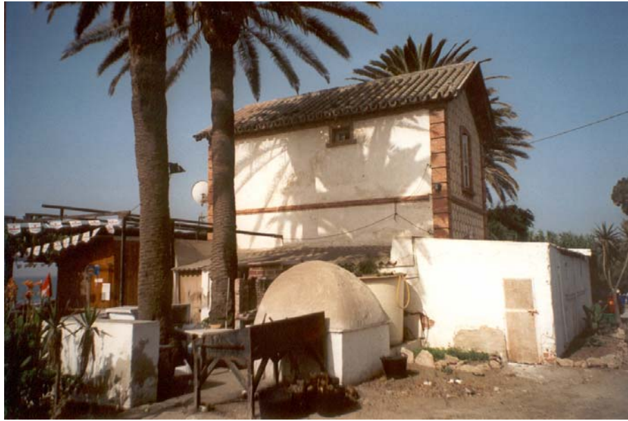
8. Estado actual del apeadero de Chilches.
