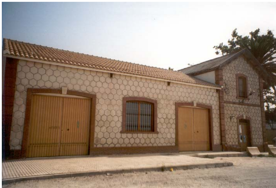
7. Apeadero de Benagalbón en la actualidad, donde se puede observar la nave que se ha adosado y que se utiliza como depuradora.
