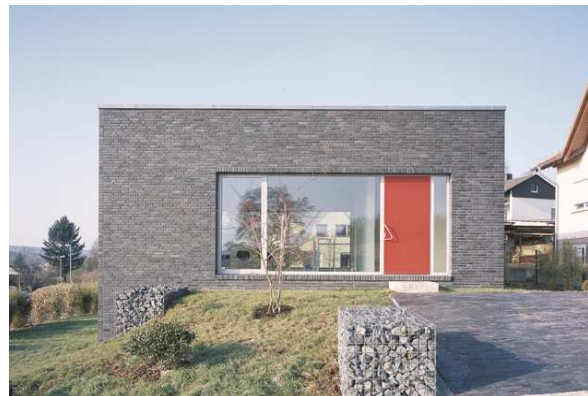
Fig. 3. Fachada de la vivienda.
