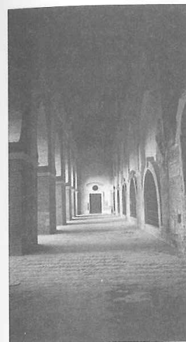
19. La galería almohade antes de las obras.
