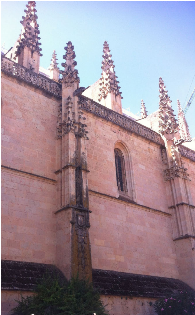
Figura 9. Muro, zócalo y contrafuerte del lienzo lateral norte de la catedral de Segovia.
