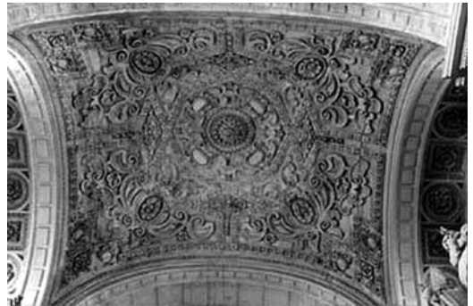
Figura 6 Bóveda vaída de la nave de El Sagrario
