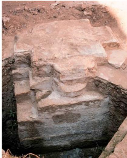
Fig. 5. Pilar arruinado y cimentación.
