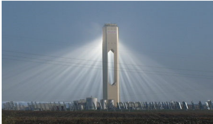
Figura 2. Vista panorámica de la planta solar de la Plataforma SOLUCAR.
