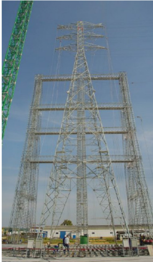
Figura 3. Instalaciones de Eucomsa.
