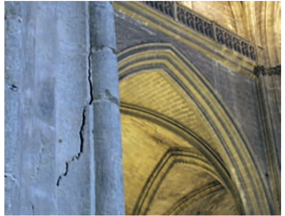
Arriba. Protección de la excavación de la cubierta. A la derecha. Grieta del pilar 4c. Fotografías: A. Jiménez.
