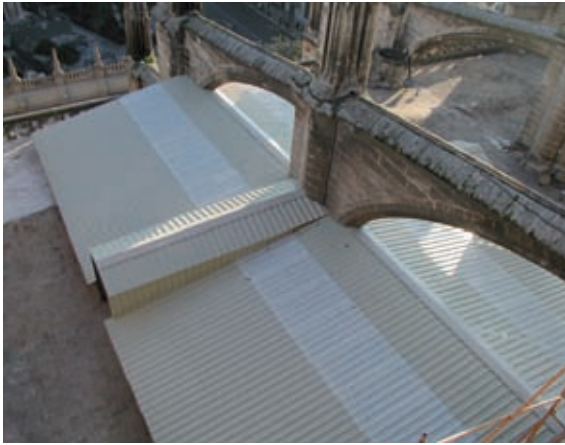
Arriba. Protección de la excavación de la cubierta. A la derecha. Grieta del pilar 4c. Fotografías: A. Jiménez.
