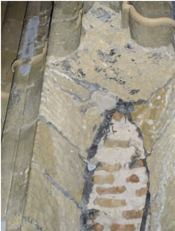
Abajo. Jeringamientos de cemento en el pilar 4C. Fotografía: J.L. Baron.
