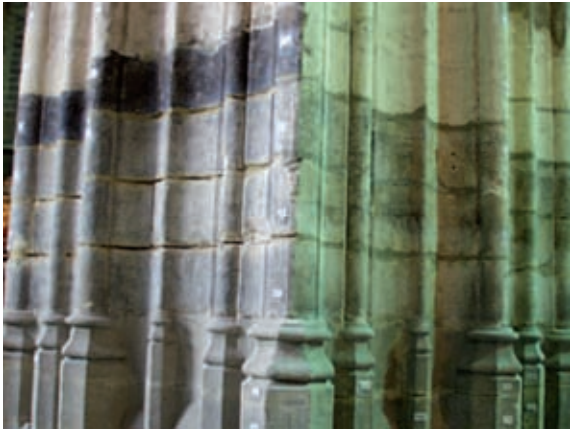
La base del pilar 5C. Fotografía: A. Jiménez.
