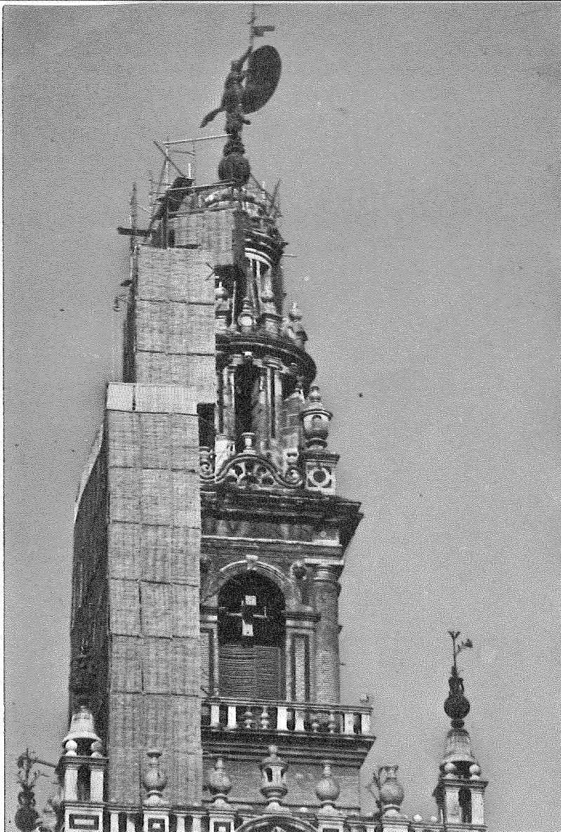
Zona superior de la Giralda, con los andamios utilizados en las obras de restauración y la gran veleta coronando la torre
