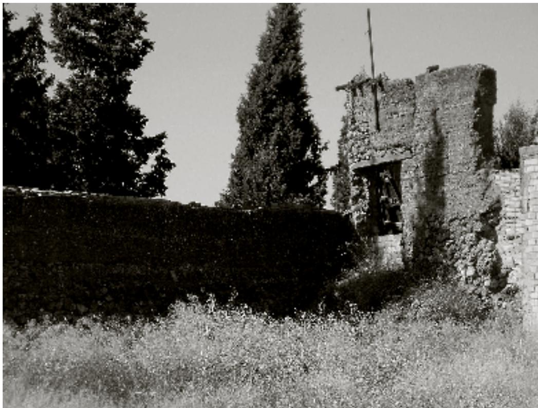
Según la cronotipología de Graciani y Tabales<sup>7</sup>, la muralla de Niebla está edificada casi íntegramente con tapia monolítica, tipo 1, aunque hay que destacar las particularidades de algunos tramos, donde existen sectores del muro levantados mediante mampostería de piedra natural, como los de los lienzos exteriores del Castillo de los Guzmanes, reformado a partir del periodo cristiano, siglos XIV al XIX.
