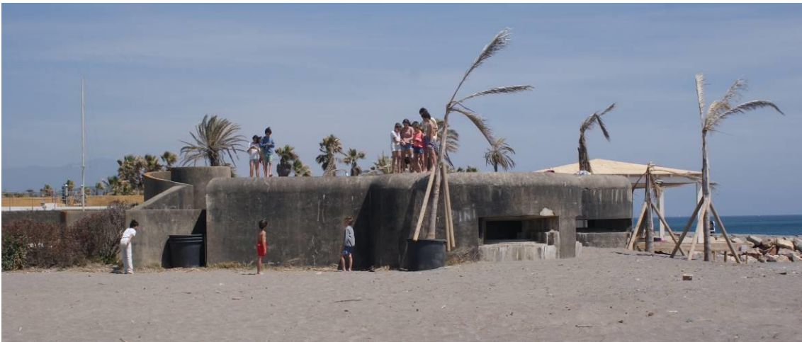
Fig. 9b. Arriba, búnker IA23, quebrado por la mitad, en la playa de Guadalquítón de San Roque. Abajo, búnker IA40, junto a la urbanización Sotogrande, en San Roque. Fotografías de los autores
