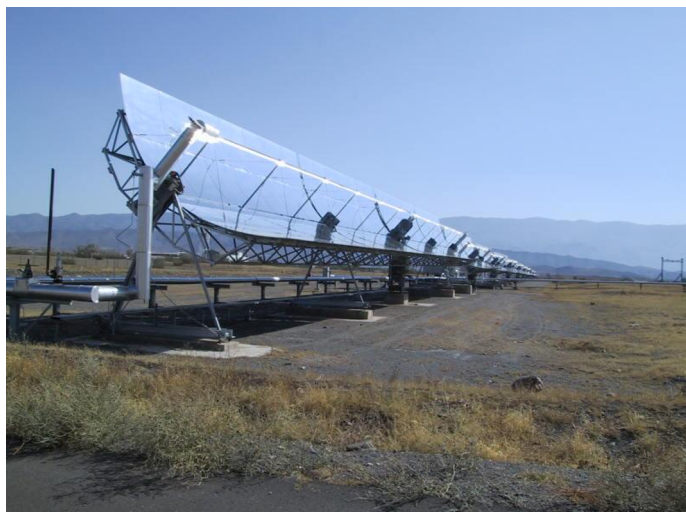
Fig. 5. DISS Parabolic trough at the Plataforma Solar de Almería
