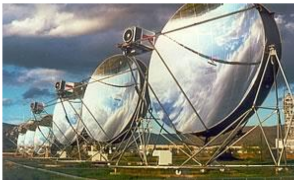
Figura 10. Central termosolar con discos parabólicos (Stirling) [8].
