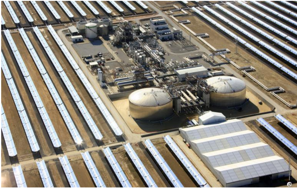
Figura 8. Planta termosolar de colectores cilindro parabólicos, Valle 1 (Cádiz, España) [7].
