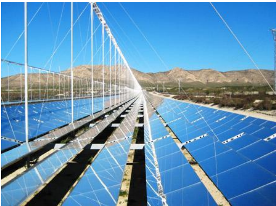
Figura 9. Central termosolar con receptores lineales Fresnel. [6]
