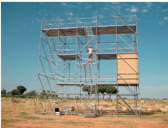
Figura 8: Escenario de validación del proyecto AWARE en las instalaciones de Protec-Fire (Grupo Iturri) en Utrera, Sevilla. La fotografía muestra la estructura usada para simular un edificio.
