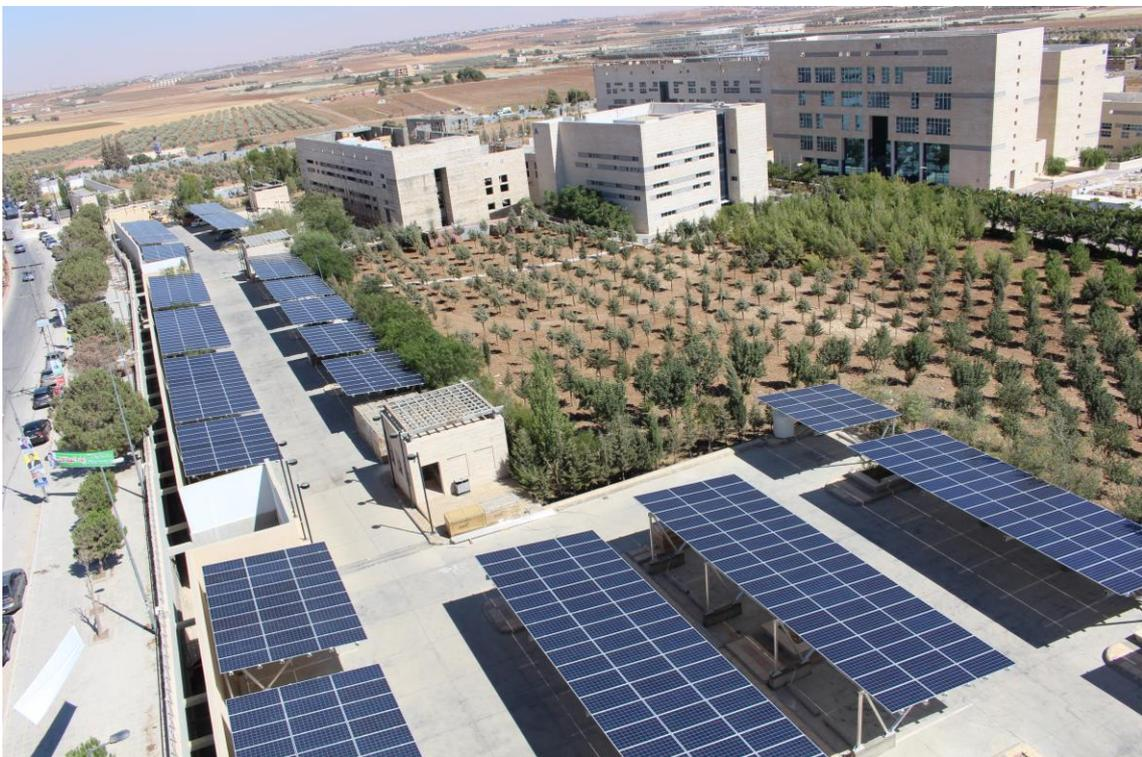
Figura 3-7. Área 2, 1146 paneles, 360.99 kW. FUENTE: [16]
