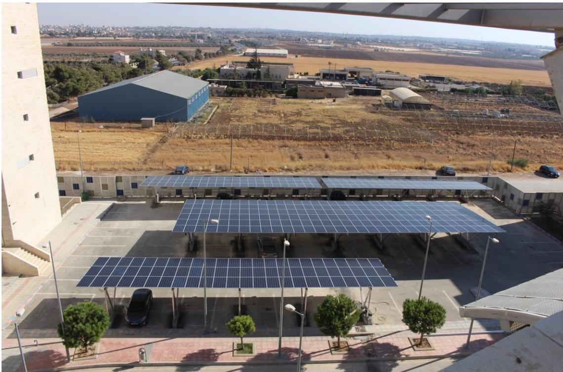
Figura 3-9. Área 5, 396 paneles, 124.74 kW. FUENTE: [16]
