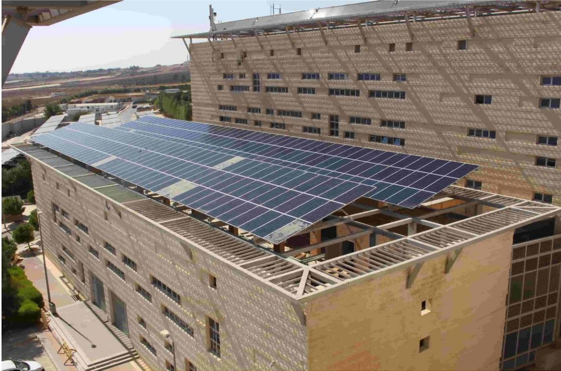
Figura 3-8. Área 4, 267 paneles, 84.112 kW. FUENTE: [16]
