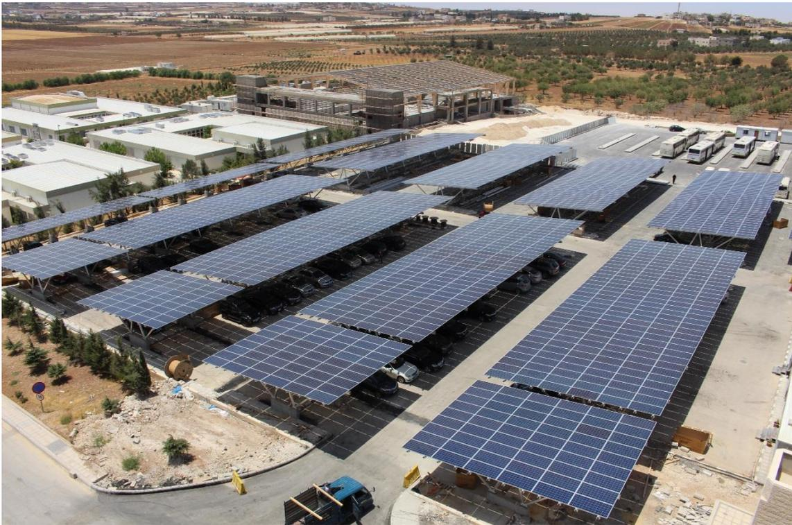
Figura 3-6. Área 1, 2250 paneles, 708.75 kW. FUENTE: [16]
