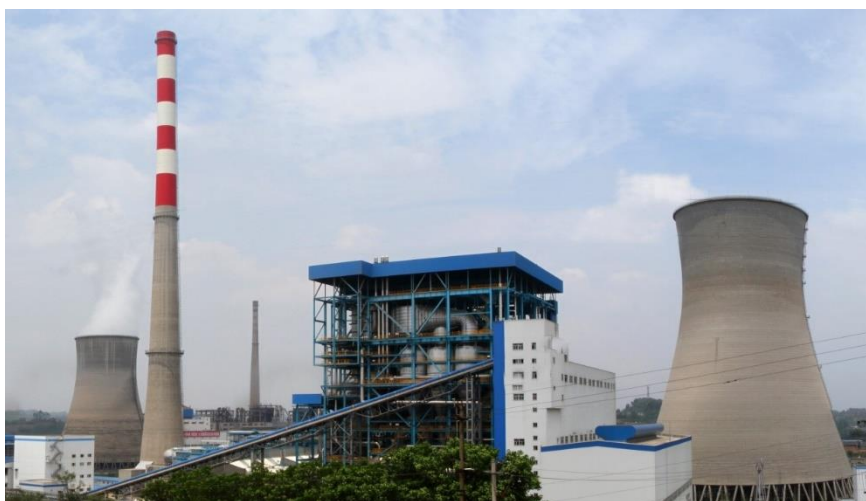
Figura 1-4. Central térmica supercrítica de 600 MWe construida en Baima, China.
