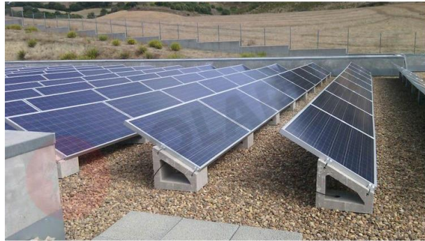
Ilustración 2.9 Estructura módulos FV.
