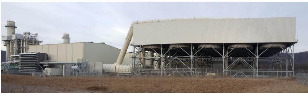
Figura 20: Aerocondensador instalado en una central de ciclo combinado.
