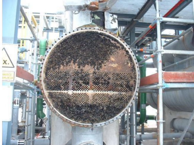
Figura 4-3 Intercambiador sucio
