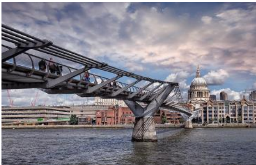
Imagen 1 Puente del milenio de Londres.
