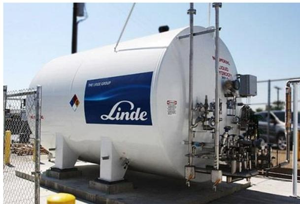
Figura 6-2. Almacenamiento estacionario de hidrógeno líquido [29]
